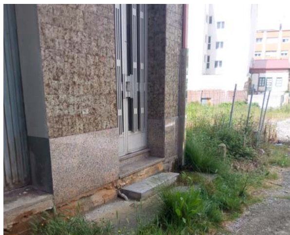
Portal final de C/ Esquío
